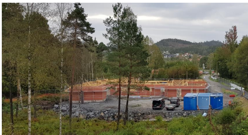
Avlastningsboliger under oppføring på Stoppedalsmyra på Birkeland.
