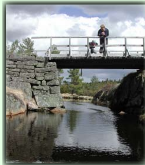
Brua over Rekslønnbekken
